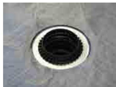
6. Bauschutz abnehmen, Trennlage auflegen, Entwässerungsring HL160 einsetzen
