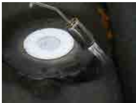
2. Werkseitigen Bitumenkragen des Ablaufs mit der bauseitigen Bitumenbahn verschweißen
