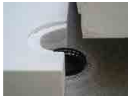
3. Trennlage auflegen, Entwässerungsring (HL180) auf den Ablaufkörper aufsetzen, Wärmedämmung anbringen
