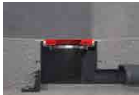
15. Bündiger Abschluss der Beschichtung mit dem Edelstahlaufsatzring.
