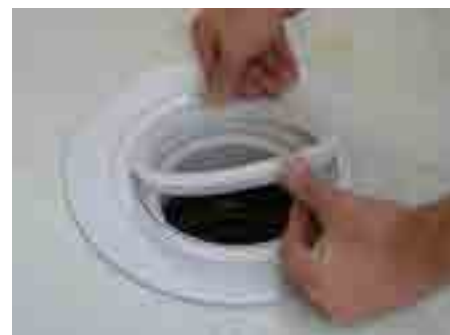
9. Transparenten Kunststoffring in die vorgesehene Ringnut des Dichtflansches einsetzen
