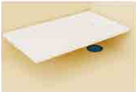
13. Duschtasse auf den Estrich versetzen
