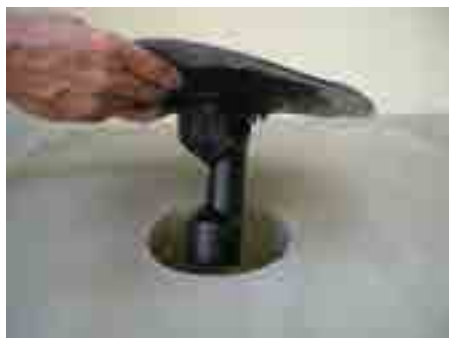
1. Ablaufkörper mit Bauschutz in den Deckendurchbruch einlegen
