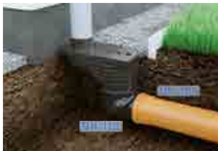
5. Kanalrohr anschließen DN110 - direkt DN125 - ablängen!
