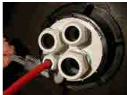
5. Leitungen/Rohre durchführen, Lagepositionierung festlegen, Klemmmutter der Durchgangsschraubungen festziehen
